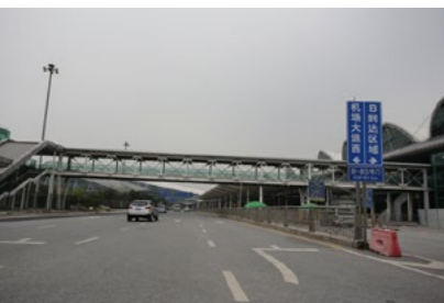
航站楼过街天桥
