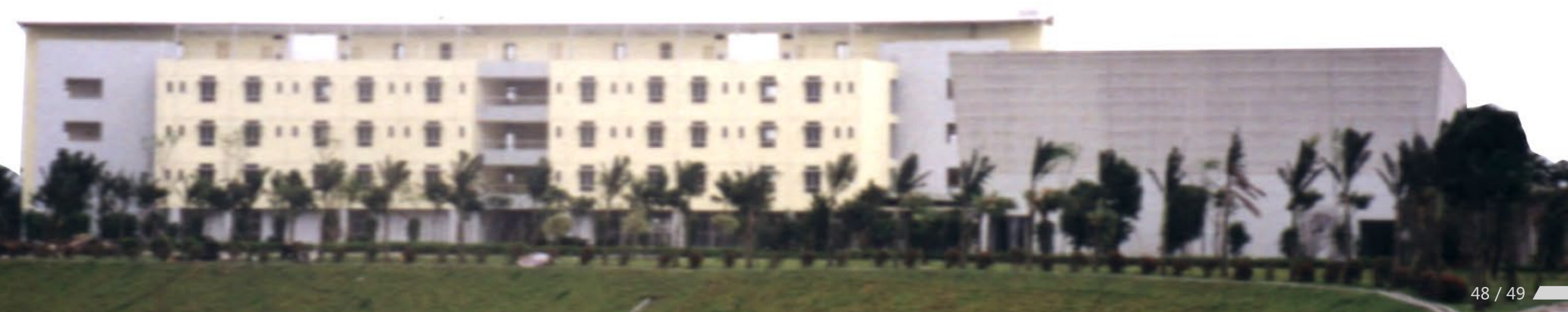
大型场馆 —— 广州国际皮划艇中心
