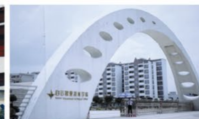
跨度 50 米，高 18 米，钢构大门造型
